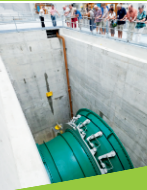
Durch eine Turbine fließen bis zu 375.000 Liter Wasser pro Sekunde.
